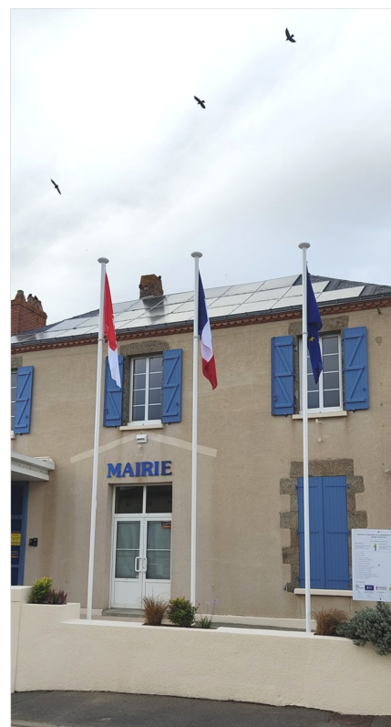
Installation de 3 mâts pour les drapeaux devant la mairie et petits travaux de rénovation par les agents communaux.
