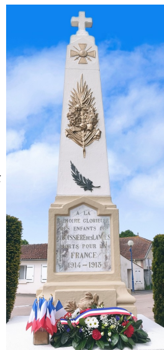
Rénovation du monument aux morts
