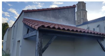
Les travaux de réfection de la couverture de l'espace jeunes
